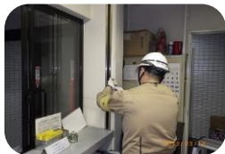
指摘事項の改修工事
