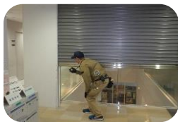
防火設備定期検査
