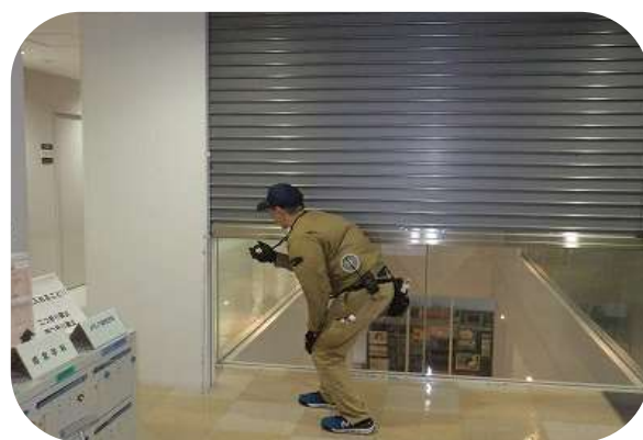
防火設備定期検査
