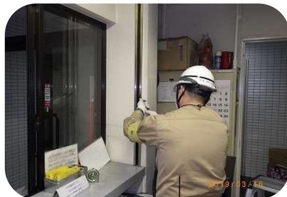
指摘事項の改修工事
