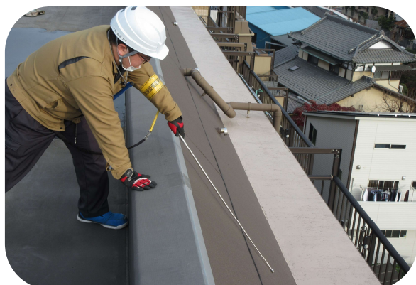
特定建築物定期調査
